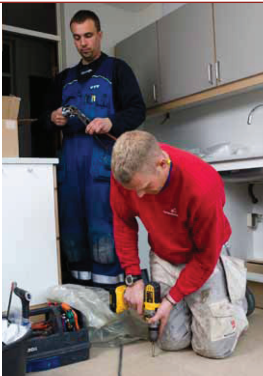
Tømrer Morten Kronborg og VVS'er Brian Møller arbejder tæt sammen om opgaverne på en større entreprise i Kolding. Det giver færre fejl og dermed gladere kunder. Foto: Helene Bagger
